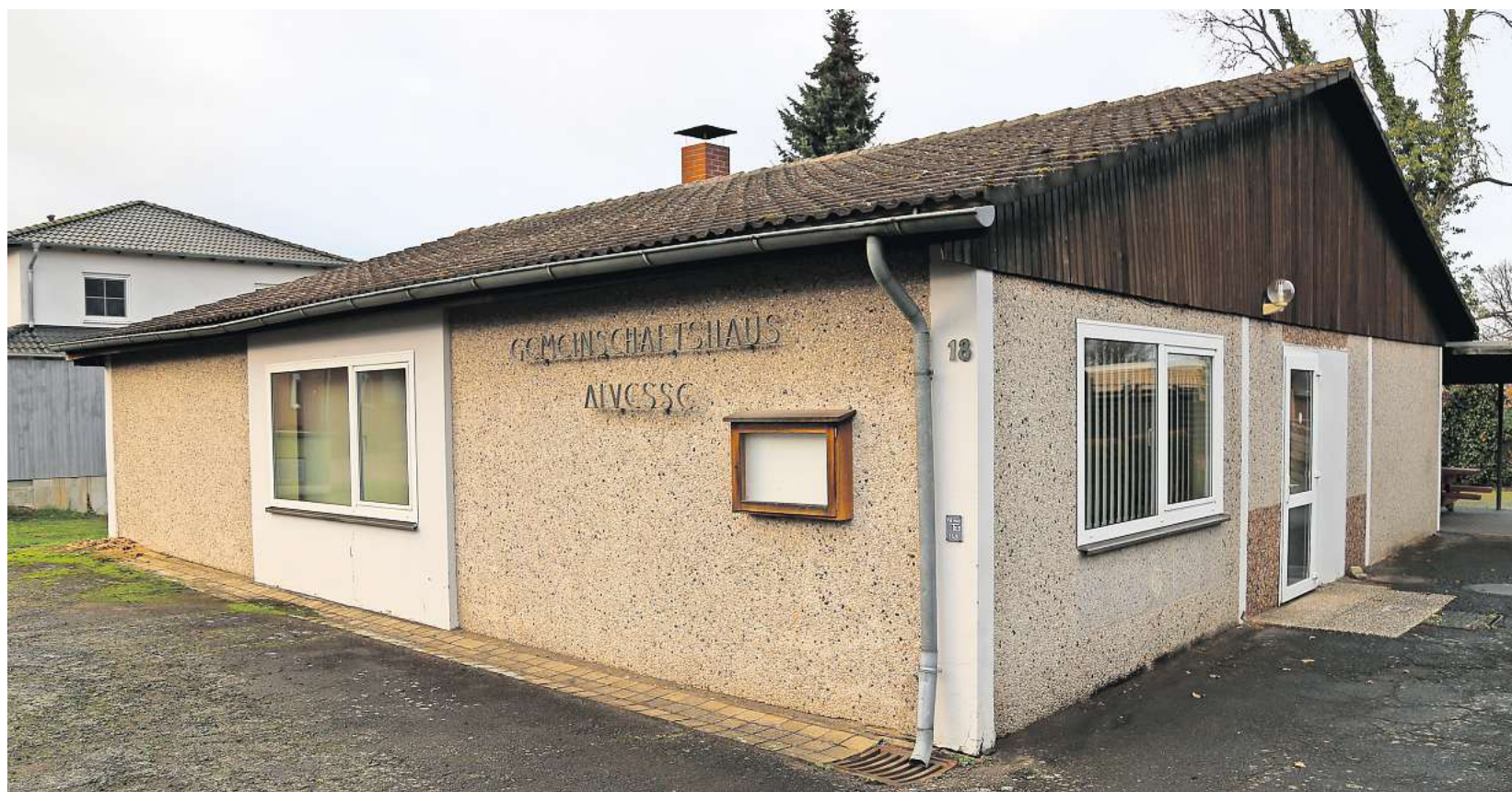
Das Dorfgemeinschaftshaus in Alvesse war einsturzgefährdet und ist inzwischen abgerissen.
