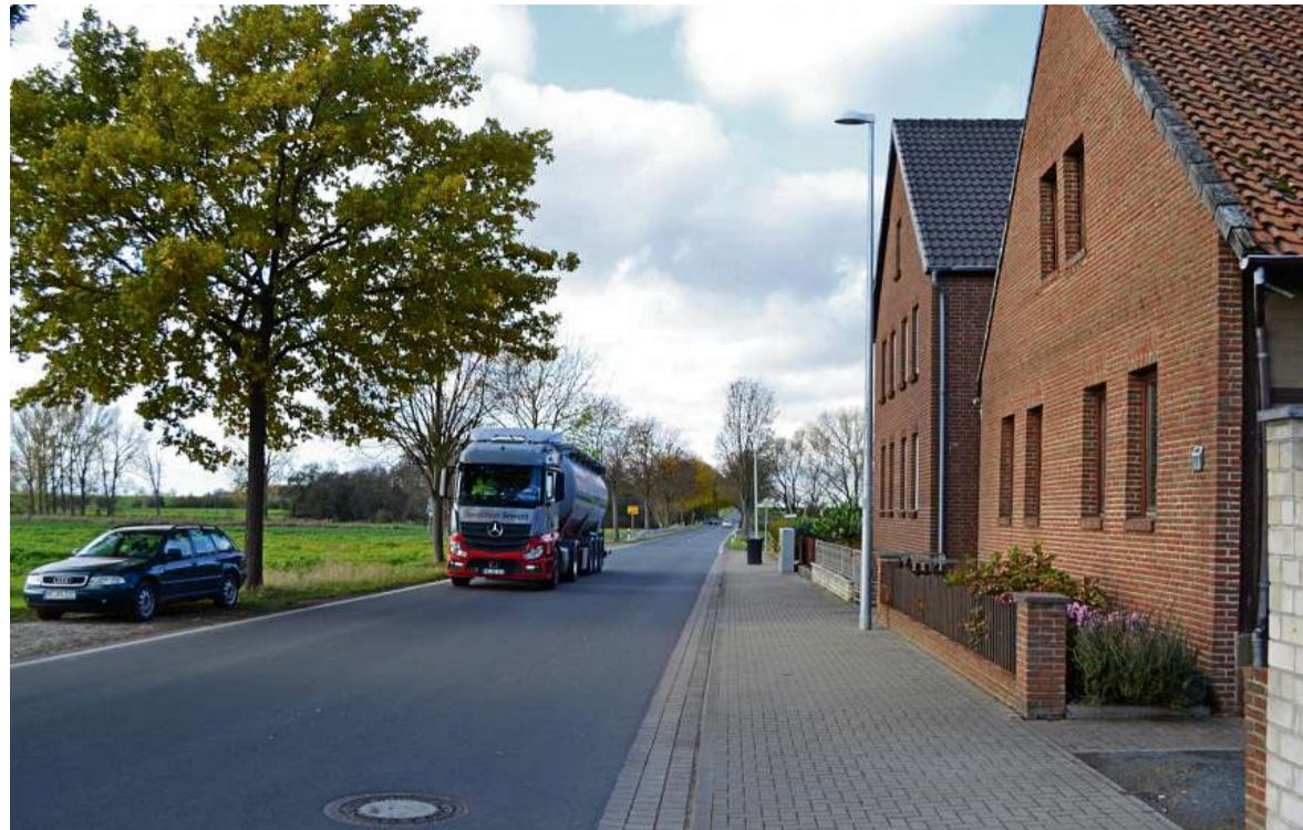
Die Landesstraße 473 erhält von Wierthe (vorne) bis zur Landesstraße 475 (hinten) einen Radweg.
