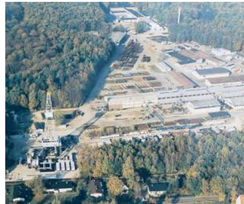
Blick auf das ehemalige Preussag-Gelände.
